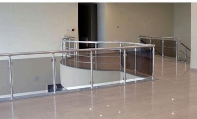
SCP aluminijuske ograde i stepenišne rampe od aluminijuma odlikuju se visokom kvalitetom i elegantnom estetikom. Prednosti aluminijuskih ograda su dug vijek trajanja, lakoća održavanja i otpornost na koroziju. Ograde su sistemske, dakle spojive vijcima i bez varenja, što dodatno doprinosi kvaliteti i jednostavnosti montaže.
